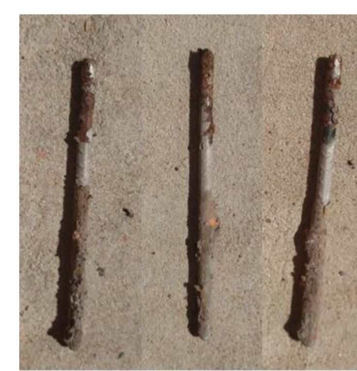
Figura 5: Corrosão nas barras de aço.
